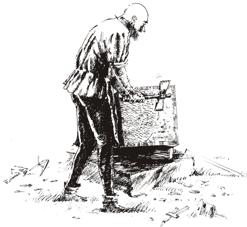
Endbearbeitung des Spiegels mit Zahnfläche oder Glatfläche
