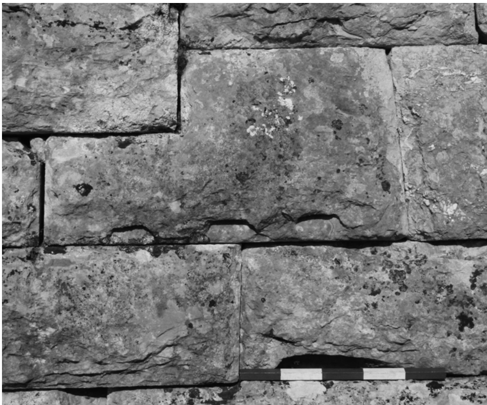
Messene, Griechenland, Stadtmauer (4. Jh. v. Chr.): Keillochhälften in der Ansichtsfläche eines Werksteines
